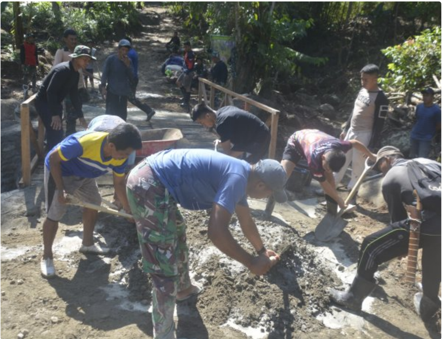
Majene - Rehabilitasi jembatan di Desa Tallambalao oleh Satgas TNI Manunggal
